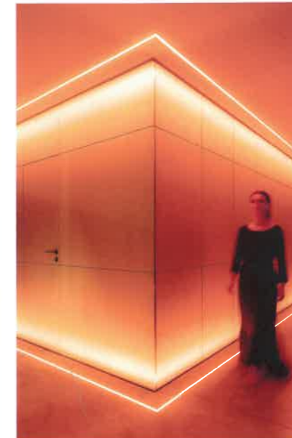
▲ Die Ausführung der feinen Underscore-Lichtlinien mit RGB-LEDs ermöglicht unterschiedliche farbige Inszenierungen.
