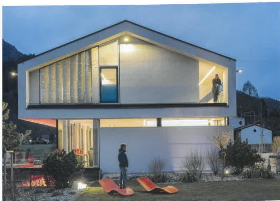
▲ Eine auf filigranen Stahlstützen schwebende Box beherbergt die Schlafräume. Der sich darunter ergebende Raum gibt dank seiner weitgehenden Verglasung im Süden einen einzigartigen Blick auf das imposante Bergmassiv des Wilden Kaisers frei.
